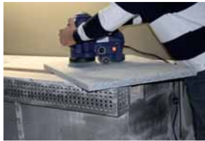
Levigatura, anche di superfici grezze Hard grinding on raw surfaces
