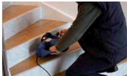
Pulizia delle scale interne Cleaning of inside stairs
